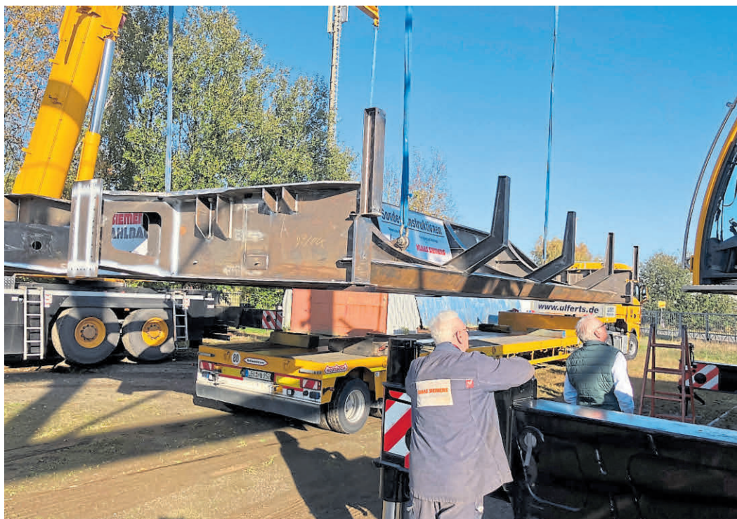
Fertigen tonnenschwere Bauteile für diverse Wasserbau-Projekte: Verladung auf dem Firmengelände von Klaas Siemens an der Auricher Straße.
